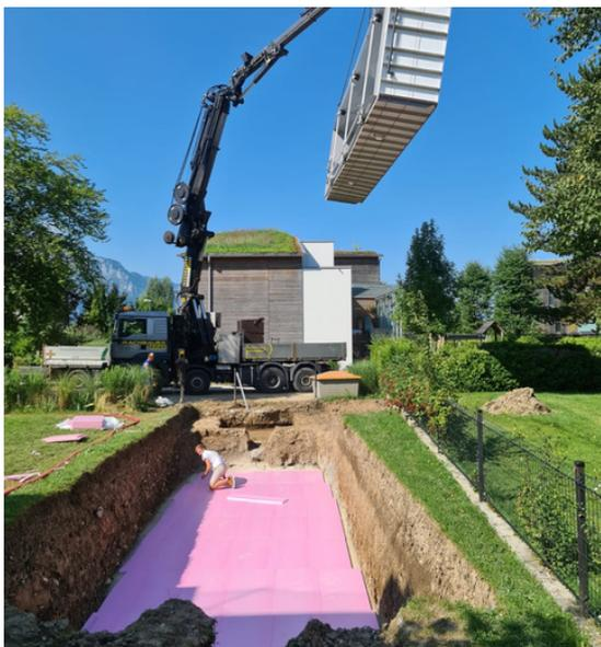
Der Aushub inkl. Hinterfüllung muss durch einen extra beauftragten Professionisten durchgeführt werden und somit geht die Haftung für die richtige Ausführung und eventuelle Folgeschäden am Pool auf den vom Kunden gewählten Professionisten zu 100% über.
